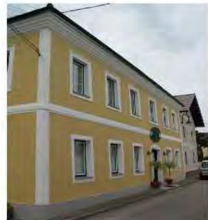
Die Fassade nach der Renovierung, durch die Malerei Blindeneder.
