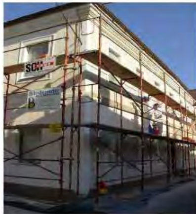
neu verputzen mit Universalputz
