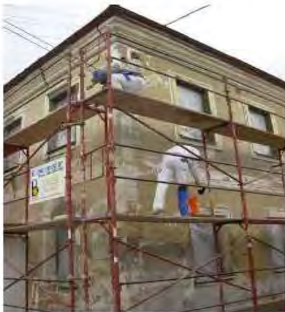
entfernen der alten Farbe
